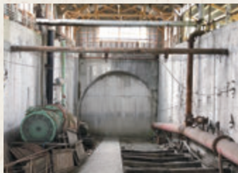
三川坑跡第二斜坑口
