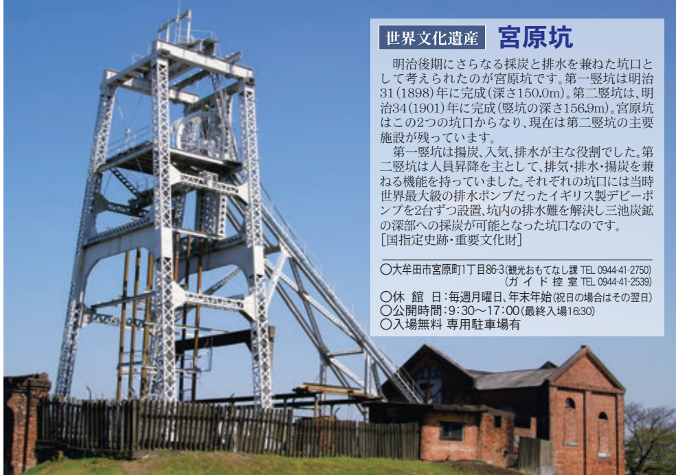
たてこうやぐら まさあげ きしつ 優美さと力強さを備える第二堅坑櫓と煉瓦造りの巻揚機室
