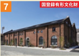
旧三川電鉄変電所
