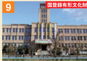
大牟田市庁舎本館
