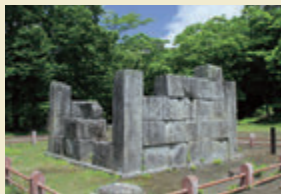
【4-1】橋野鉄鉱山 三番高炉跡
